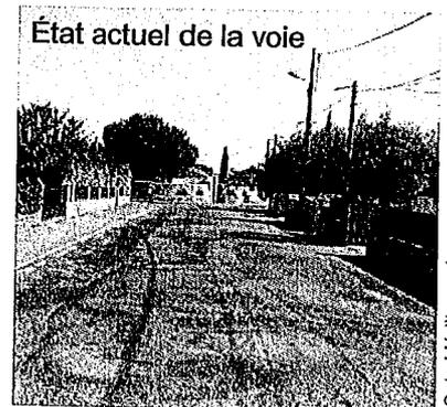
Dans cette voie de desserte, il est proposé de calibrer la chaussée à 5 m de large pour réaliser des trottoirs. Du stationnement peut aussi être matérialisé le long d'un côté de la voie, de préférence en alternance pour former des chicanes. D'autres dispositifs de modulation de la vitesse pourront éventuellement être réalisés (coussins, plateau...).
