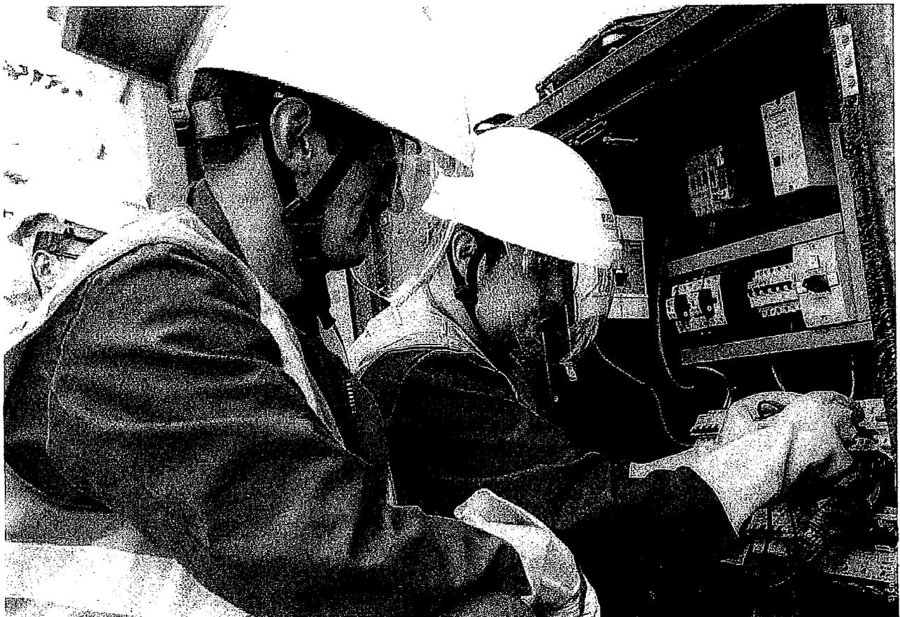
Vérification de tension et puissance à l'armoire - La maintenance fait partie intégrante de l'efficacité énergétique.
