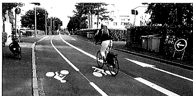
Rue de la Croix Sourdeau, Saint-Sébastien sur Loire (mise en sens unique de la voie pour créer une piste cyclable bidirectionnelle)
