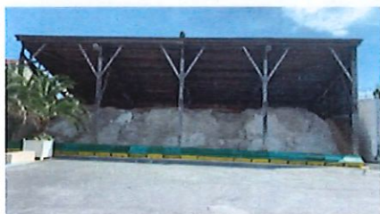
Stock en alvéoles, couvert sur plateforme étanche avec récupération des eaux de chauxée.
