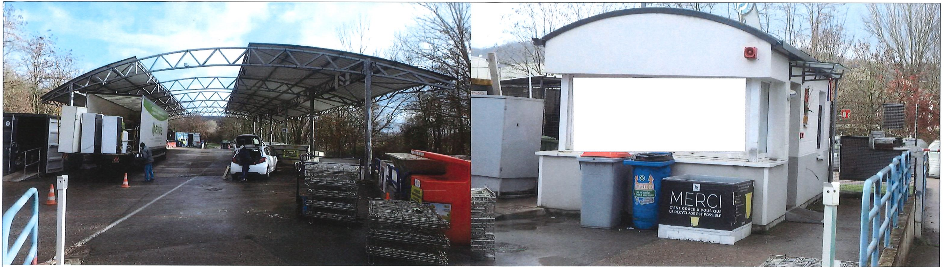
A.2 PHOTOGRAPHIE DES BATIMENTS A DEMOLIR
