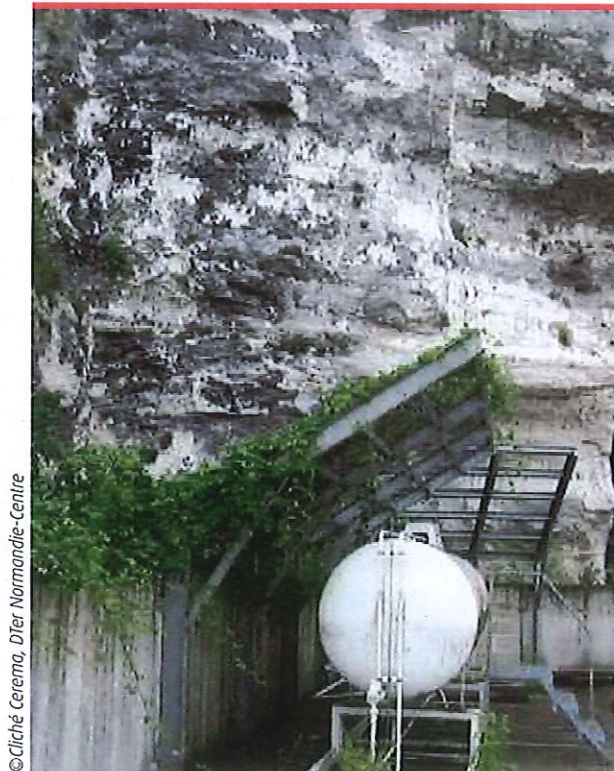
Protection d'une cuve sous une falaise en Seine-Maritime
