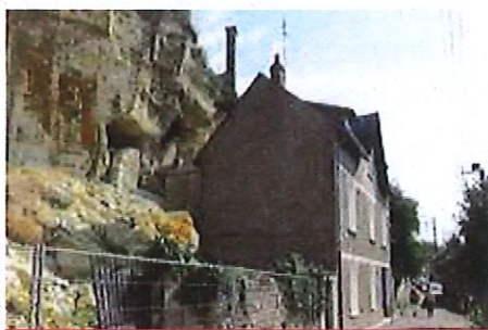
Chutes de blocs à Rochecorbon (Indre-et-Loire). Dommage fonctionnel pour la maison.
